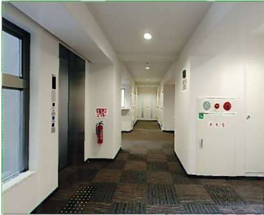
《 共有スペース(1F廊下) 》
